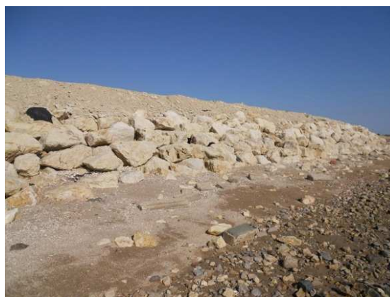
Photographie 17 Vue sur la digue de la SACOM
