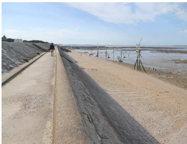
Photographie 2 Vue sur la digue SNCF
