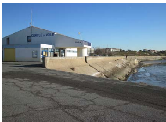
Photographie 13 Vue sur l'ouverture qui permet l'accès à la digue du port
