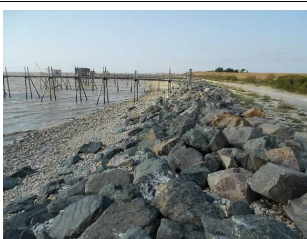
Photographie 19 Vue sur la digue du lieu-dit « Près des fontaines »
