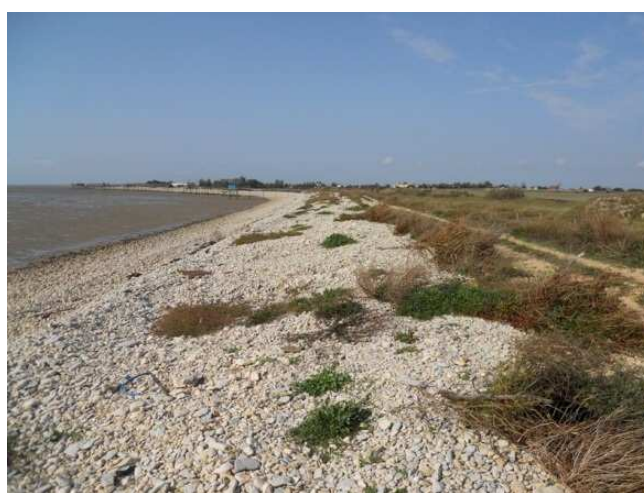
Photographie 20 Vue sur la digue de l'anse de Fouras
