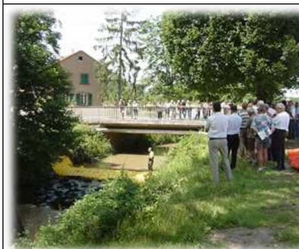
Figure 3 Démonstration de la barrière anti-inondation « Watergate » au Salon de la protection individuelle à Hattmatt, 2012 (CG67)
