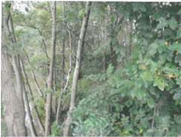
Figure 109 : Secteur aval de la digue, entièrement boisé
