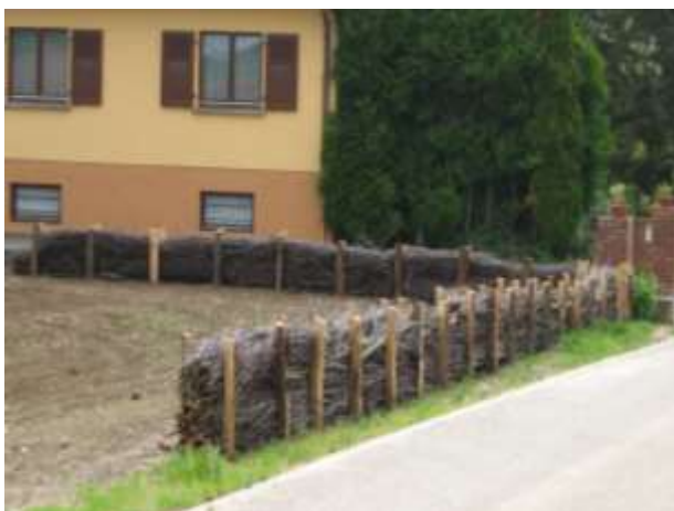
Figure 121 : Une fascine à Wittersheim Source :L. Hoerd, CD67
