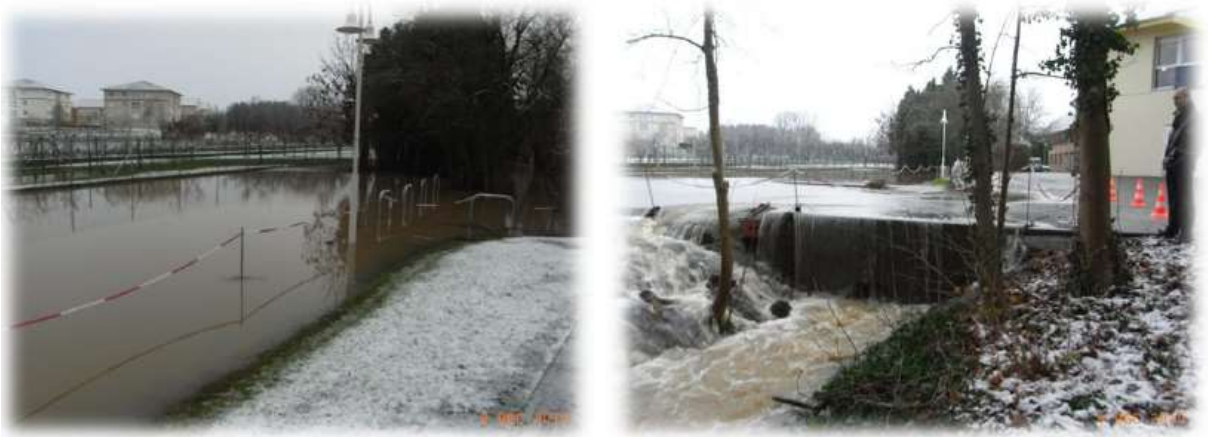
Figure 61: Mise en charge de l'ouvrage O2 – 09 Décembre 2010 (Artelia, 2013)
