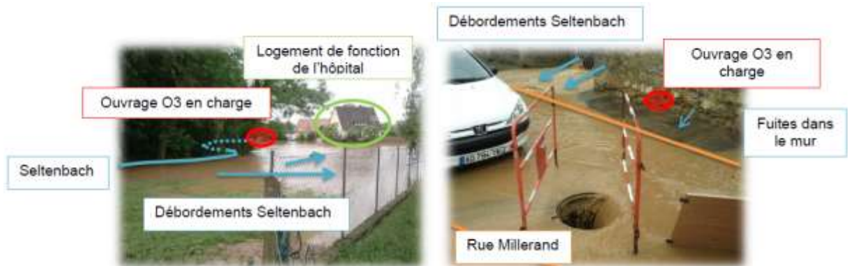
Figure 58: Propagation de l'onde de submersion lors de l'inondation du 21 mai 2012 au niveau de l'ouvrage O3 - photographies prises le 22 mai à 10h (Artelia, 2013)
