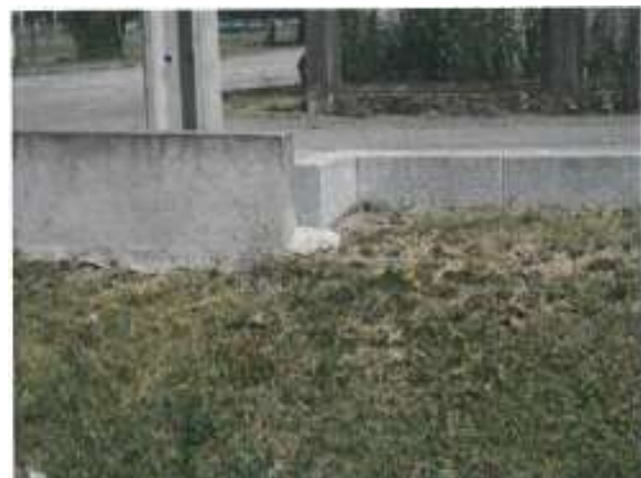
Figure 107 : Jonction entre le mur et le muret, rue du Chanvre
