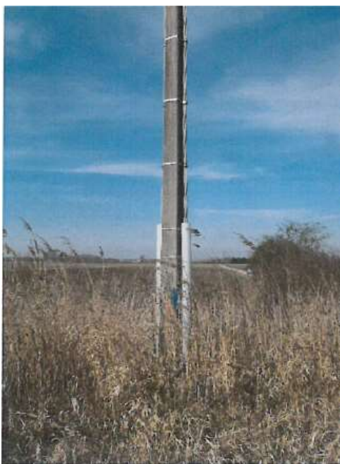
Figure 102 : Pylône implanté dans le talus côté zone protégée
