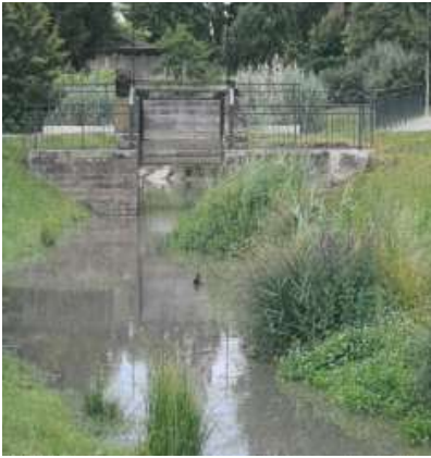
Figure 104 : Vannage sur le Kleinbach
