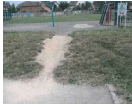
Figure 105 : Dégradation de la crête au niveau du terrain de sport de sport
