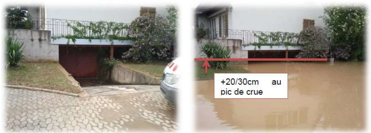
Figure 59: Impact de l'inondation du 21 mai 2012 sur le logement de fonction de l'Hôpital – photographie de droite prise le 22 mai à 12h (Artelia, 2013)
