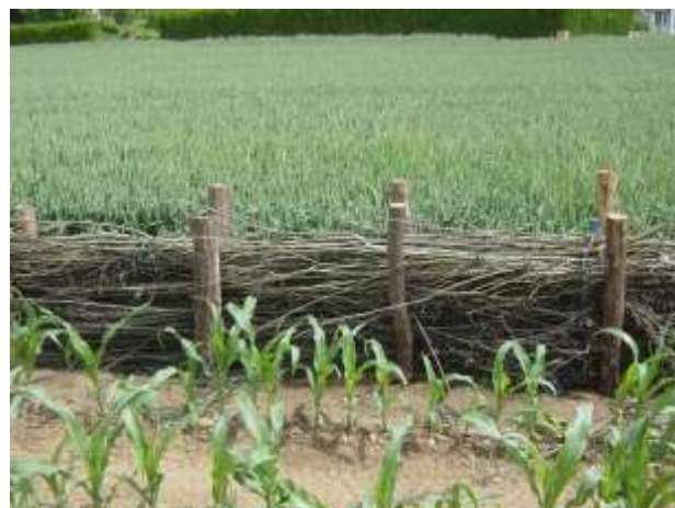
Figure 122 : Fascines en saule à Ettendorf Source : CD67
