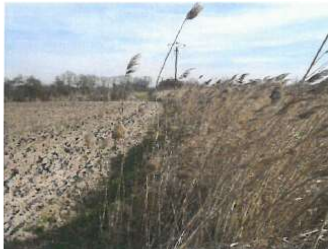
Figure 100 : Talus recouvert de végétation côté zone protégée Source : Rapport d'inspection de la digue du 11 mars 2014, DREAL Alsace
