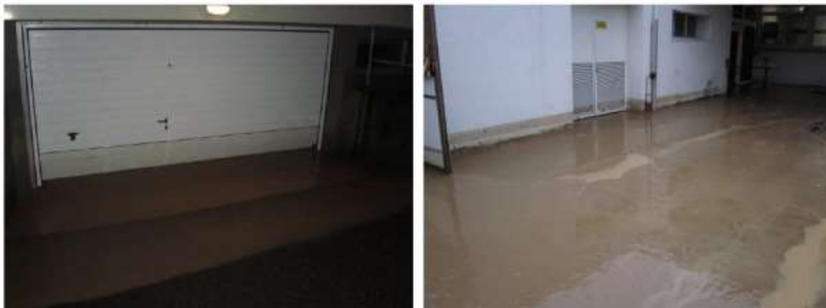
Figure 70: Photos de la crue de 2012 : à gauche, porte de garage du niveau -1 du siège Adidas (face Nord) - à droite : magasin Adidas (face Nord) (Artelia, 2015)
