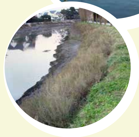
▲ Berges de l'étier de la Torre à La Baule-Escoublac.
