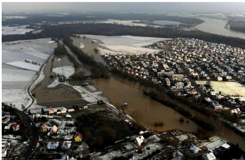
Figure 44 : Crue de la Moder à Drusenheim le 09/12/2010.
