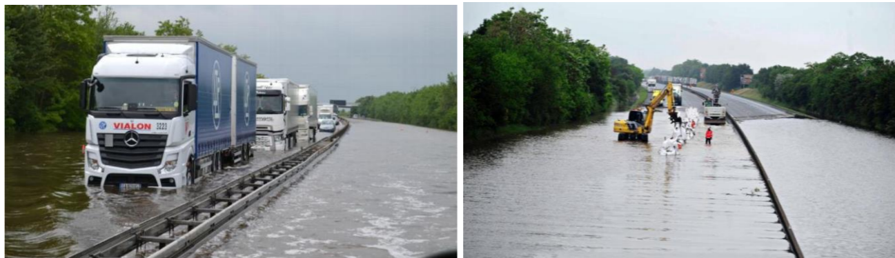
Figure 29 : Photographies de l'autoroute A10 coupée lors des événements de 2016 (Source : http://www.larep.fr/ - © Orléans AGENCE)
