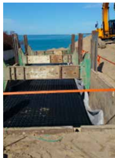
Illustration 27 : Travaux de création d'ouvrage de gestion des eaux pluviales, Casino Arcachon
