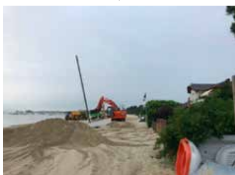
Illustration 26 : Travaux maritimes plage de Bélisaire, 2017
