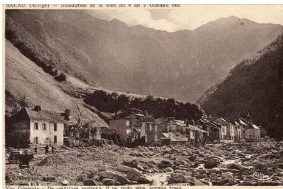
Figure 15 : prise de vue des dégâts de la crue des 4 et 5 octobre 1937 à Salau
