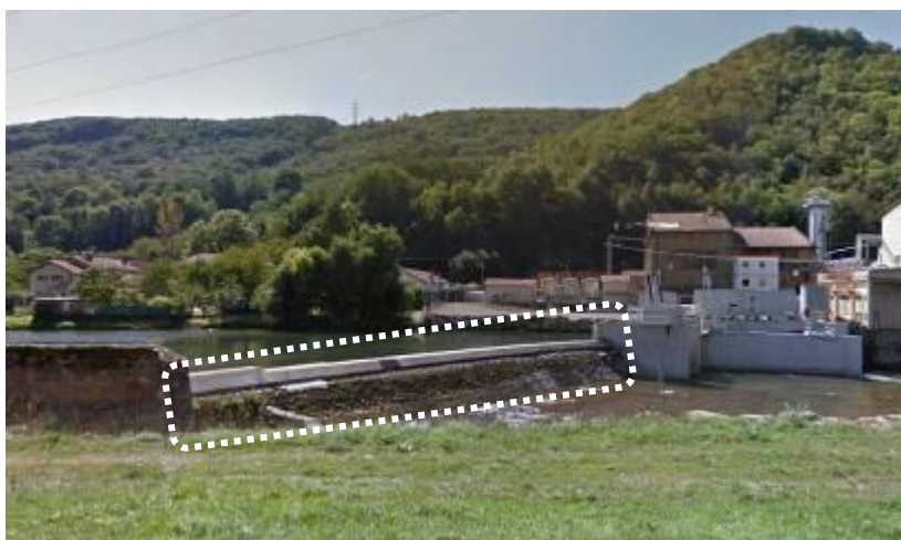
Figure 566 : barrage de La Mourlasse sur le Salat à Eycheil-Encourtiech avec sa rehausse visible en crête
