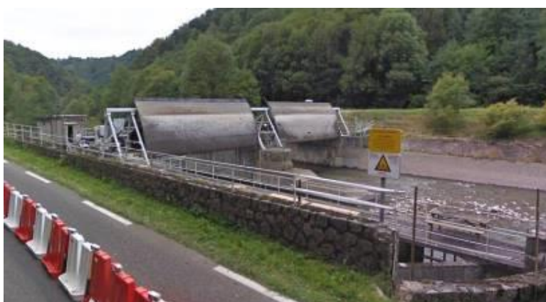
Figure 577 : barrage de Quercabanac sur le Salat à Soueix-Rogalle avec ses 2 vannes secteurs visibles
