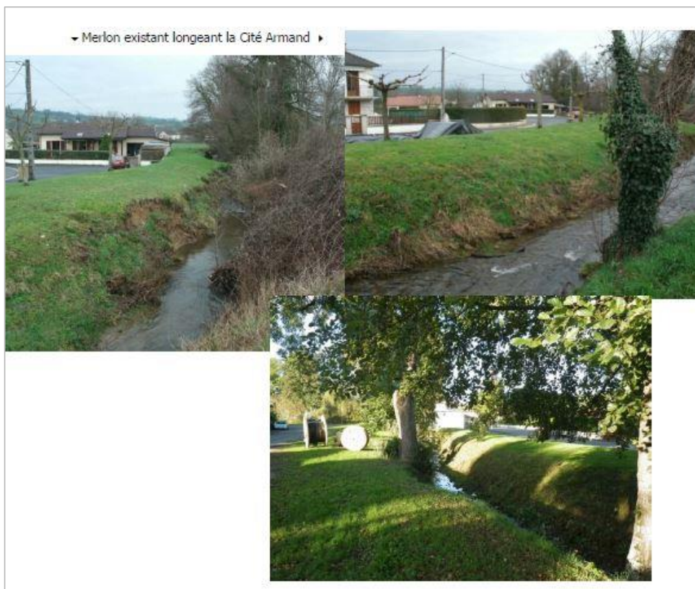
Figure 28 : Remblai de protection le long de l'Arcambe à Saint-Etienne-de-Maurs (Photo : SmCLm)
