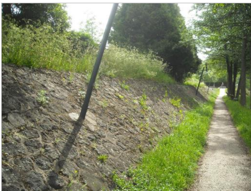
Figure 23 : Digue de la Vigière à Saint-Flour (Photo : SOMIVAL, 2015)
