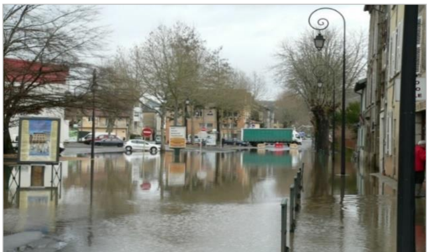
Figure 44 : Inondation dans Figeac, 2009 (Source : SmCLm)
