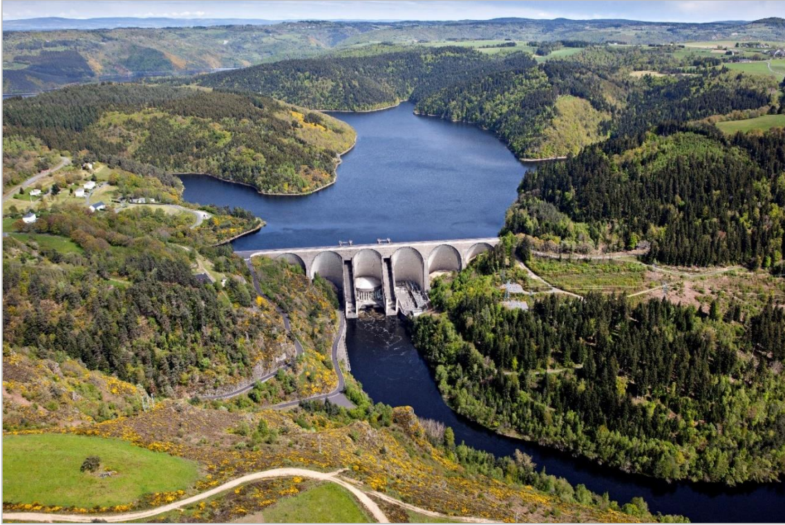
Figure 2 : Barrage de Grandval sur la Truyère (Crédit photo : EDF)
