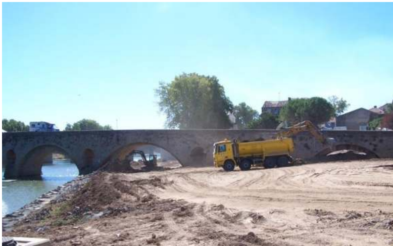
En haut : Travaux de dégagement des arches du Pont Vieux à Béziers
