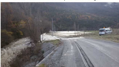
Débordement de la Blaisance sur la route départementale
