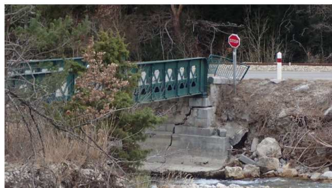
Pont de Baumugne – culée rive droite
