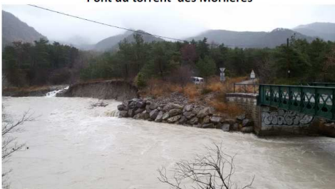
Début contournement du pont de Baumugne
