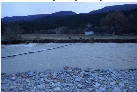
Conduite d'eau potable à Barret-sur-Méouge
