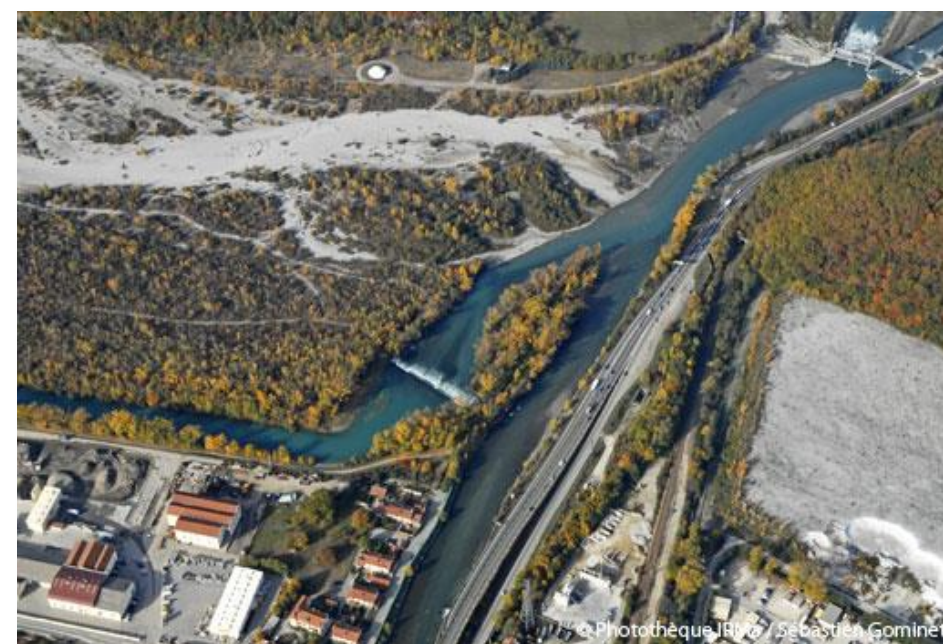
Figure 1 Vue aérienne de la confluence Drac-Romanche (Source : IRMA)
