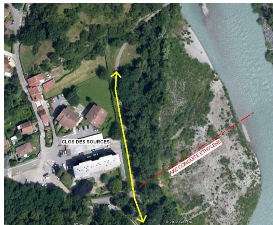
Figure 73 Vue aérienne de la digue des Ridelets (Source : ARTELIA, 2013)
