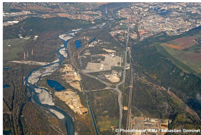
Vue aérienne du Drac en aval du Saut du Moine (Source : IRMA)
