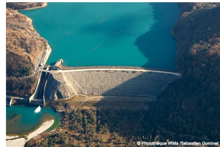
Barrage de Notre-Dame-de-Commiers (Source : IRMA)
