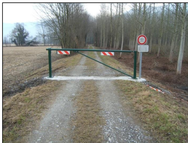
Figure 1. Exemple d'un portail sur une digue
