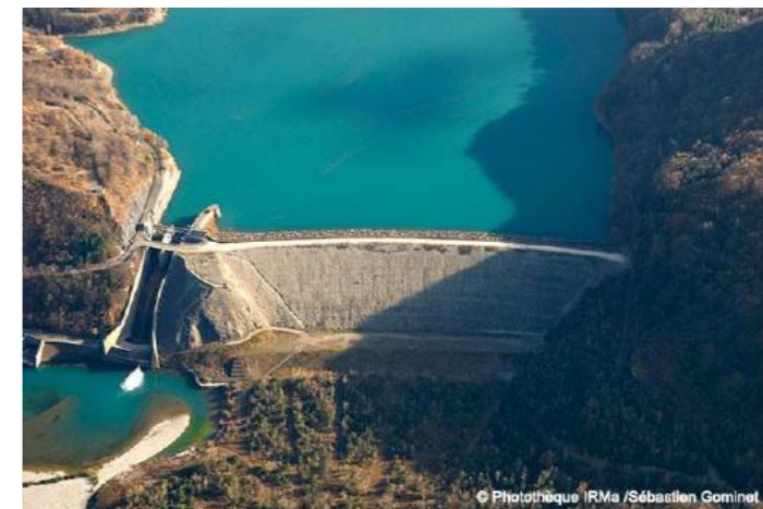
Barrage de Notre-Dame-de-Commiers (Source : IRMA)
