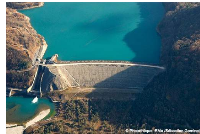
Barrage de Notre-Dame-de-Commiers (Source : IRMA)
