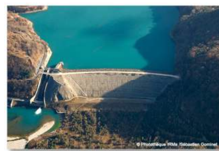
Barrage de Notre-Dame-de-Commiers (Source : IRMA)
