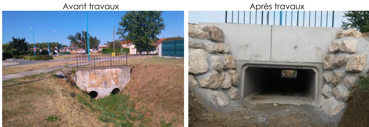
FIGURE 14 : OUVRAGE RÉDUISANT LES ÉCOULEMENTS DU SARRASCLÉ À LABARTHE-SUR-LÈZE
