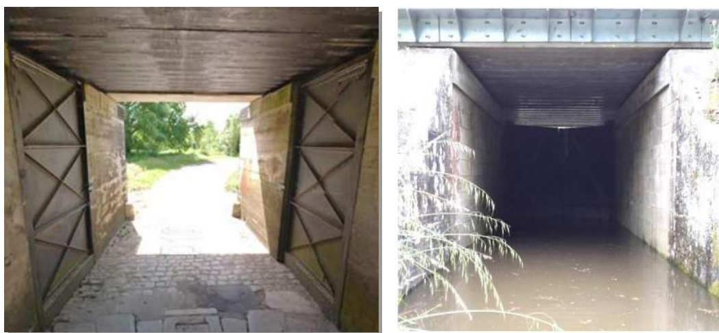
Figure 48 : Exemples de porte écluse ouverte (à gauche) et fermée (à droite) (Source : EP Loire)
