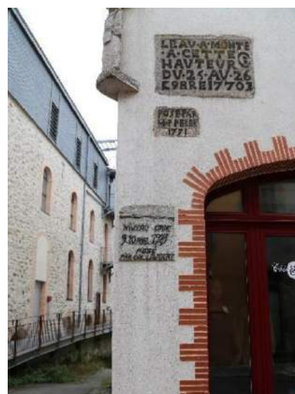
Figure 8 : Repères de crue de 1770 (au-dessus de la porte) et de 1983 (au niveau de la porte) à Clisson (Source : Inventaire des crues de l'EPTB Sèvre Nantaise)
