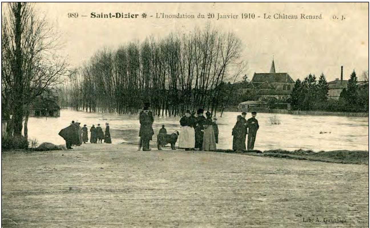
Figure 8 : Crue de la Marne à Saint-Dizier en janvier 1910. Source : Cartes postales Haute-Marne
