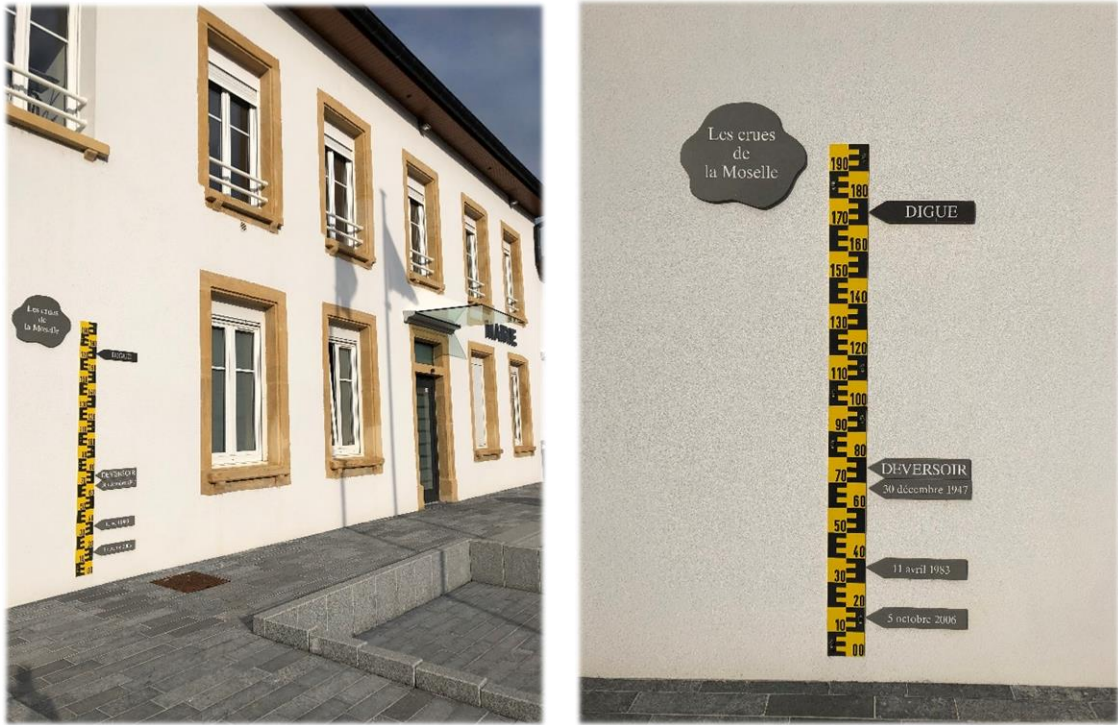
Figure 58 : Repères de crue sur la Mairie de Hauconcourt en Moselle. (Syndicat Mixte Moselle Aval© -04/12/2018)
