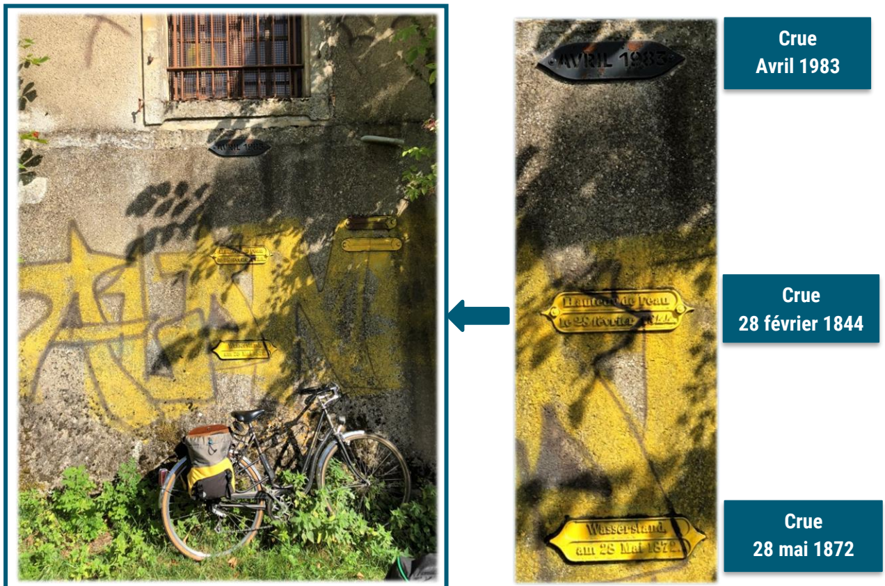
Figure 59 : Repères de crue à Corny-sur-Moselle. (Syndicat Mixte Moselle Aval© - 08/09/2018)
