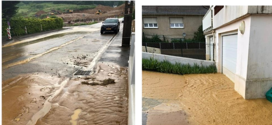
Figure 44 : Ruissellement à Volkrange 08/10/06/2018 (Communauté d'agglomération Portes de France Thionville©)
