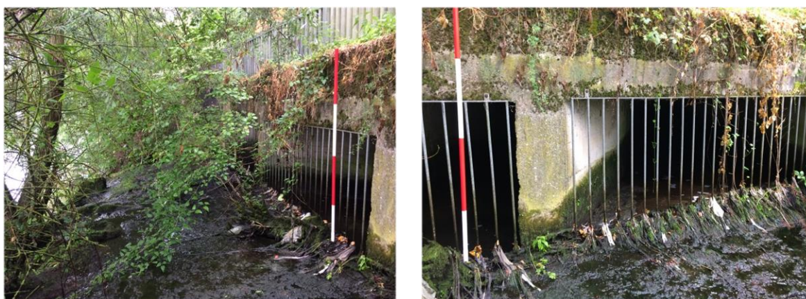
Figure 63 : Exutoires des canalisations des stations de pompage anti-crue de la ZAE Actisud- Commune de Montigny-lès-Metz (Syndicat Mixte Moselle Aval© - 01/08/2018)
