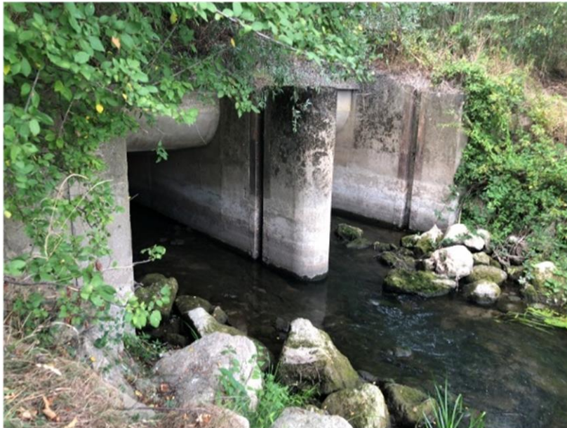
Figure 30 : Aqueduc du ruisseau du Moulon- secteur de Dieulouard (Syndicat Mixte Moselle Aval© - 23/08/2018)
