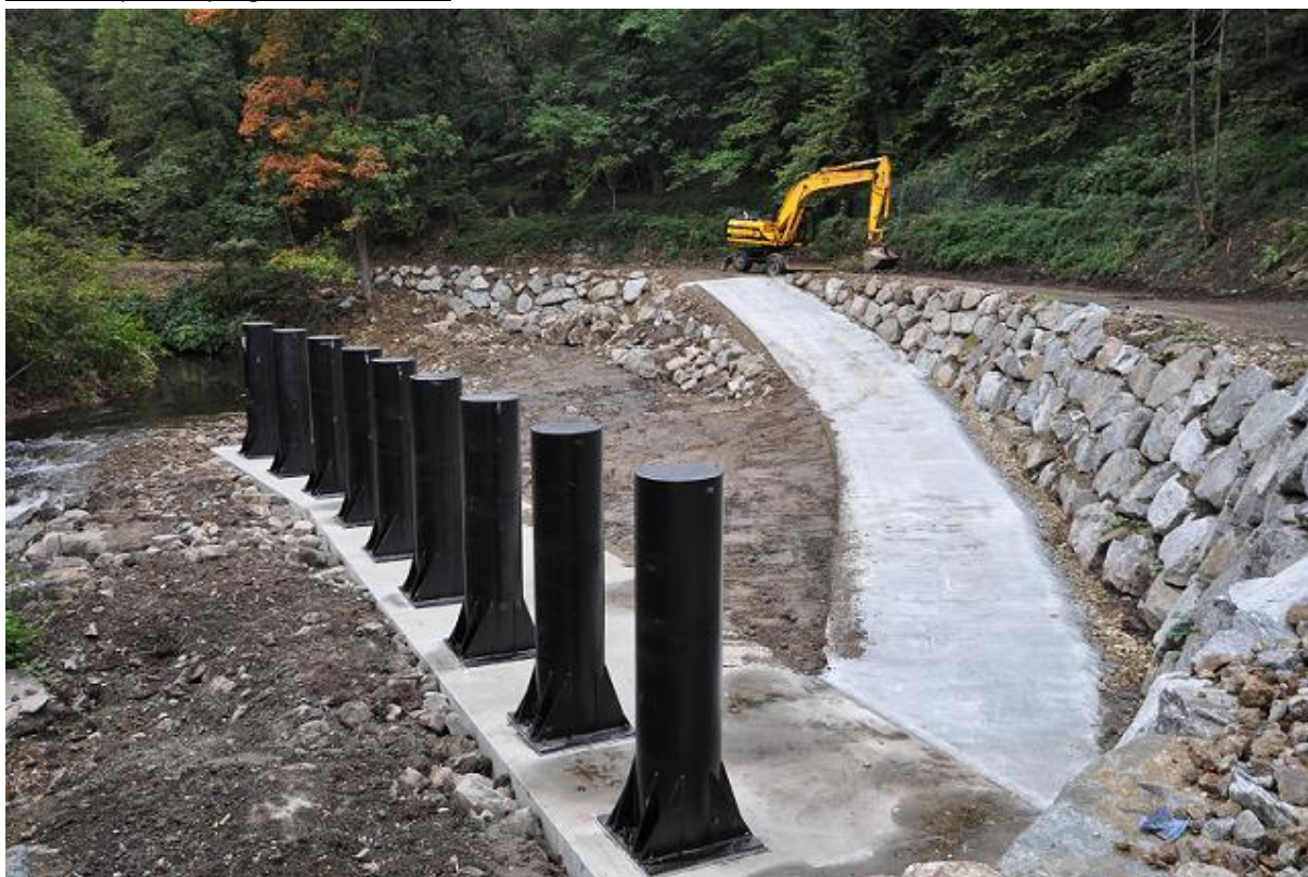
Figure 2 : Illustration de la réalisation d’un piège à embâcles en lit majeur (rivière Deûme – commune Annonay)
