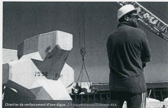
Chantier de renforcement d'une digue. / © Roberto Cascuri/Contrasto-REA
