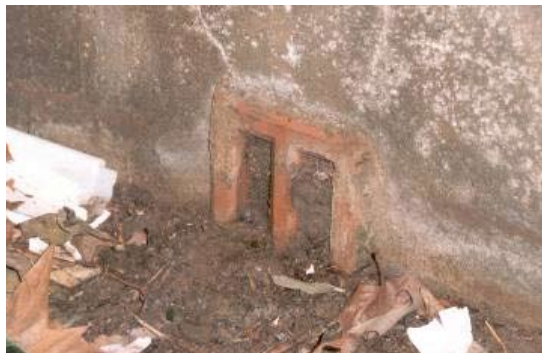
Endommagement après pénétration d'eau à travers une entrée d'air. (CSTB)
