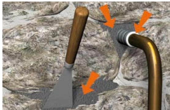
Situation après travaux : colmatage des voies d'eau.
