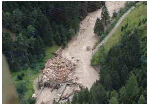
Photo 2.6 : Divagation d'une rivière torrentielle provoquée par l'obstruction d'un pont par des flottants lors des crues d'août 2005 (Autriche)
