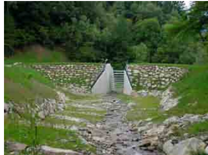
Photo 2.19 : Plage de dépôt - Verdun sur Ariège
