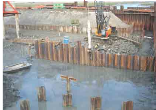
Photo 6.13 : Rideau de palplanches en acier
