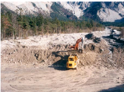
Photo 2.21 : Opération de curage - Tréminis
