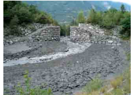
Photo 2.20 : Plage de dépôt - Saint Martin la Porte
