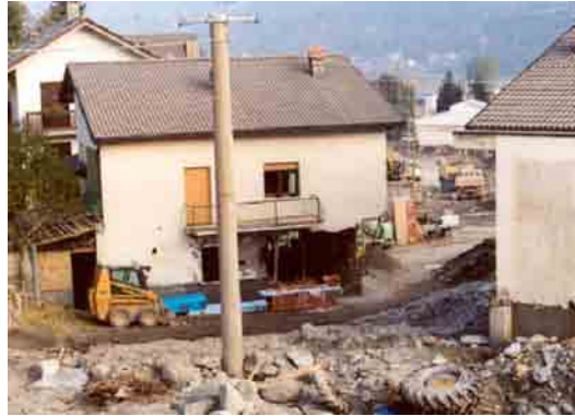
Photo 6.8 : Val d'Aoste 2000, endommagement d'un angle
