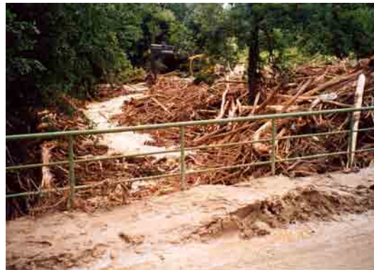
Photos 2.7 : Formation d'embâcles au droit d'un pont Saint-Geoire-en-Valdaine
