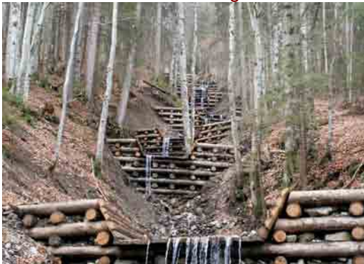
Photo 6.12 : Morzine ouvrages en bois
