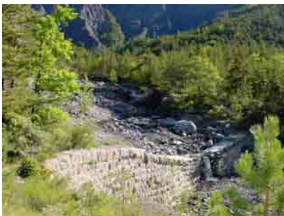
Photo 2.15 : Barrage en maçonnerie – Villeneuve d'Entraunes
