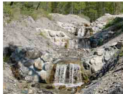
Photo 2.16 : Barrages en enrochements - Embrun
