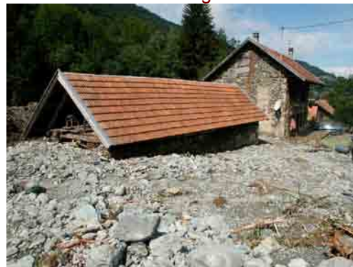
Photo 2.2 : Dépôts de charriage faisant suite au débordement et à la divagation d'un torrent - Saint Agnès
