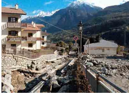
Photo 6.9 : Val d'Aoste 2000, destruction des réseaux
