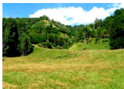
Photo 2.25 : Digue de déviation de coulée de lave torrentielle – Loudenvielle
