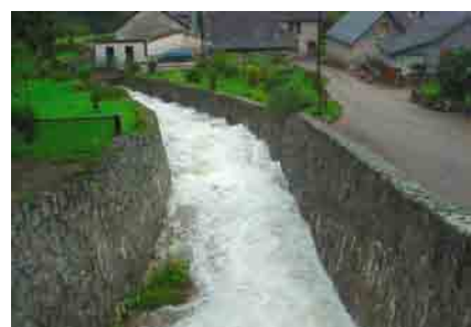
Photo 2.26 : Canalisation d'un torrent - Bielle
