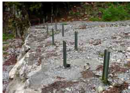
Photo 2.22 : Piège à flottants - Eaux Bonnes
