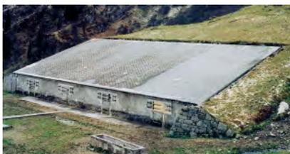
On nomme toit-terrain une construction dont le toit est raccordé sans discontinuité au terrain naturel ou à un remblai du côté amont. Ainsi, l'avalanche passe par-dessus le bâtiment. Il y a lieu d'accorder une attention particulière à
