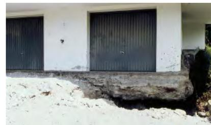
menacée selon le type de fondation et le concept statique de la construction. La stabilité globale est assurée tant que seule une petite partie du bâtiment est touchée.
