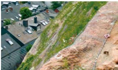
*c) Ouvrages de soutènement / ancrages*
