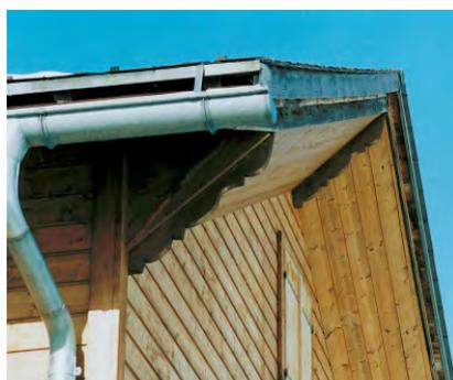
Si le danger est dû à une avalanche poudreuse, il faut éviter les avant-toits ou les protéger par un coffrage. On choisira des tuiles aussi lourdes que possible ou des modes d'accrochage capables de résister aux surpressions et aux sous-pressions.
