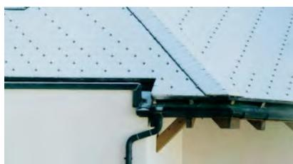
des parois latérales, pour autant qu'ils soient suffisamment protégés. Les chevrons et les pannes de ces avant-toits latéraux doivent être ancrés dans la maçonnerie.
