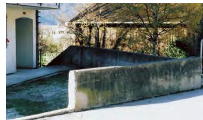
épisode pluvieux auxquelles il faut s'attendre. Lorsqu'une étrave se prolonge le long d'un objet menacé sous la forme de murs en L, il n'est pas nécessaire d'appliquer d'autres mesures sur l'objet lui-même. Sinon, il y a lieu de prendre en considération les actions exercées habituellement par la pression et par les frottements sur les parois latérales.
