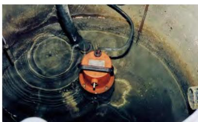
Pour une plus ample considération, il y a lieu de se référer aux normes SIA 272 (Etanchéité des ouvrages enterrés) et SIA 274 (Etanchéité des joints dans la construction). S'il subsiste un risque résiduel de percolation, celui-ci peut être réduit efficacement en plaçant une pompe immergée dans le sous-sol.
