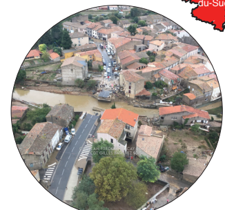
Vue de Villegailhenc, source Cdt Biscay et Barthez. Aude / octobre 2018 : 220 M€ de dégâts, 15 décédés.
