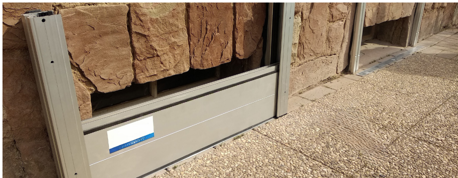
Installation de batardeaux Source : SDEA
